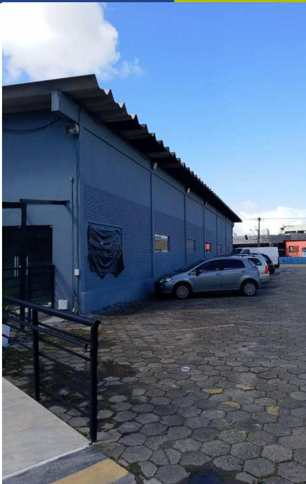
*Reforma do anexo (Bloco A) com fechamento de trincas, conserto e troca de telhas do telhado, pintura*
